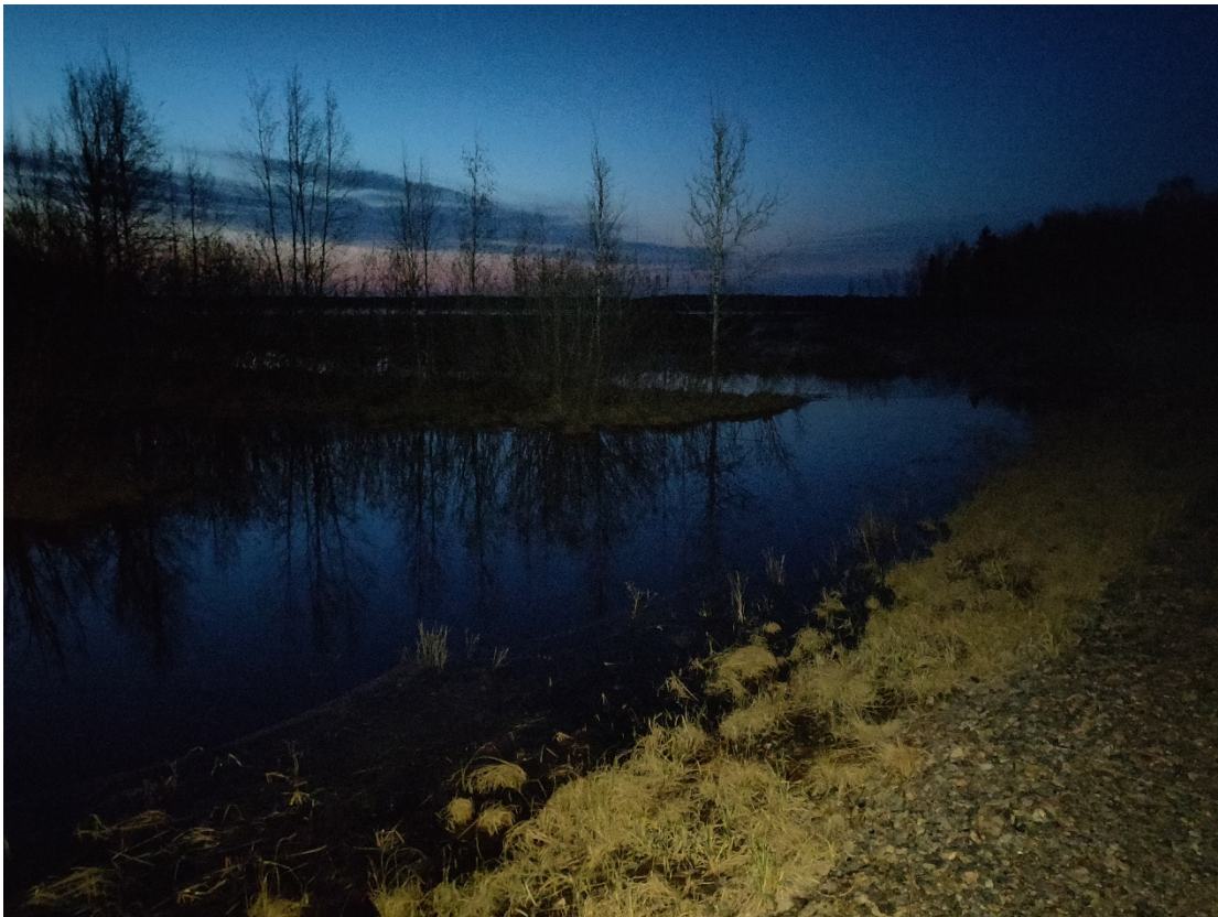
Kuva 8. Kallosaarenpiston keskimmäinen rakennuspaikka. Tien itä- ja luoteispuolen rakennuspaikoilla vesi ylsi lähes tielle asti.
