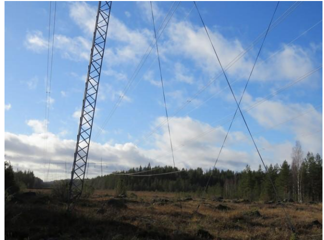
Kuva 22. Voimalinja Hautanevan luoteispuolella, kuvattu I Lounaaseen.
