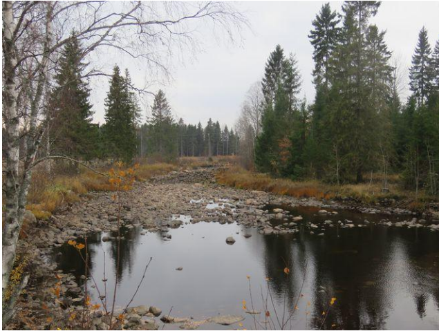
Kuva 3. Kuivalla jäänyt Alajoen uoma voimalan kohdalla.
