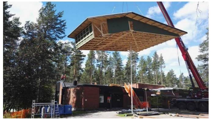
Kuvassa seurakuntatalon katon korotus 2016
