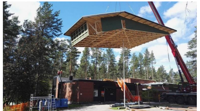
Kuvassa seurakuntatalon katon korotus 2016
