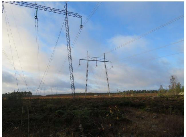
Kuva 4. Voimalinja Ahvenlamminnevan kohdalla hankealueen pohjoispuolella, etelälöinaaseen.
