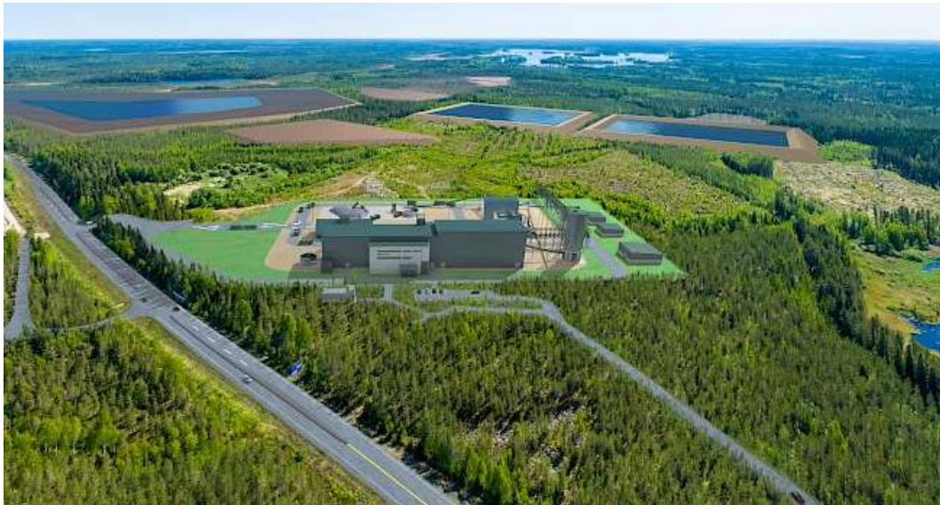
Kuva 14. Havainnekuva Kalaveden rikastamon rakenteista. Etualalla rikastamon rakennukset ja taustalla rikastamon toimintoihin liittyvät allas- ja läjitysalueet.
