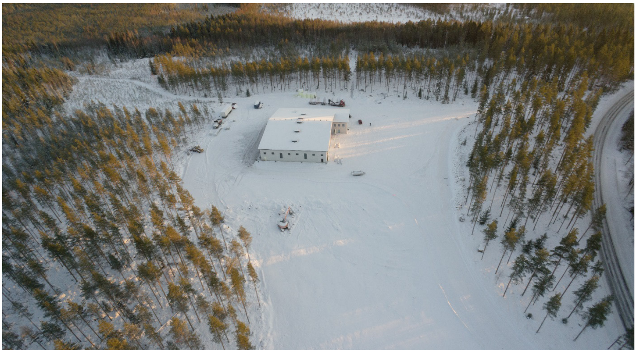
Kuva 3. Viistoilmakuva koillisesta lounaseen päin kuvattuna (Lähde: Pohjanmaan Raskasvaruste Oy, 2016)
