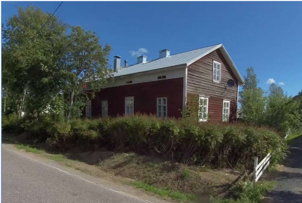
Kuva 3. Finnin talo Pajalantien varrella. © Google
