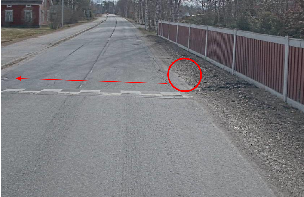
Kuva 1. Pl 1/1850 sijaitsevan töyssyn päässä vesi lammikoituu. Madollisen uuden sadevesikaivon ja purkputken paikka osoitettu punaisella, mikäli kuivatusta ei saada muuten järjestyseen. Kuva Tiekuva.com
