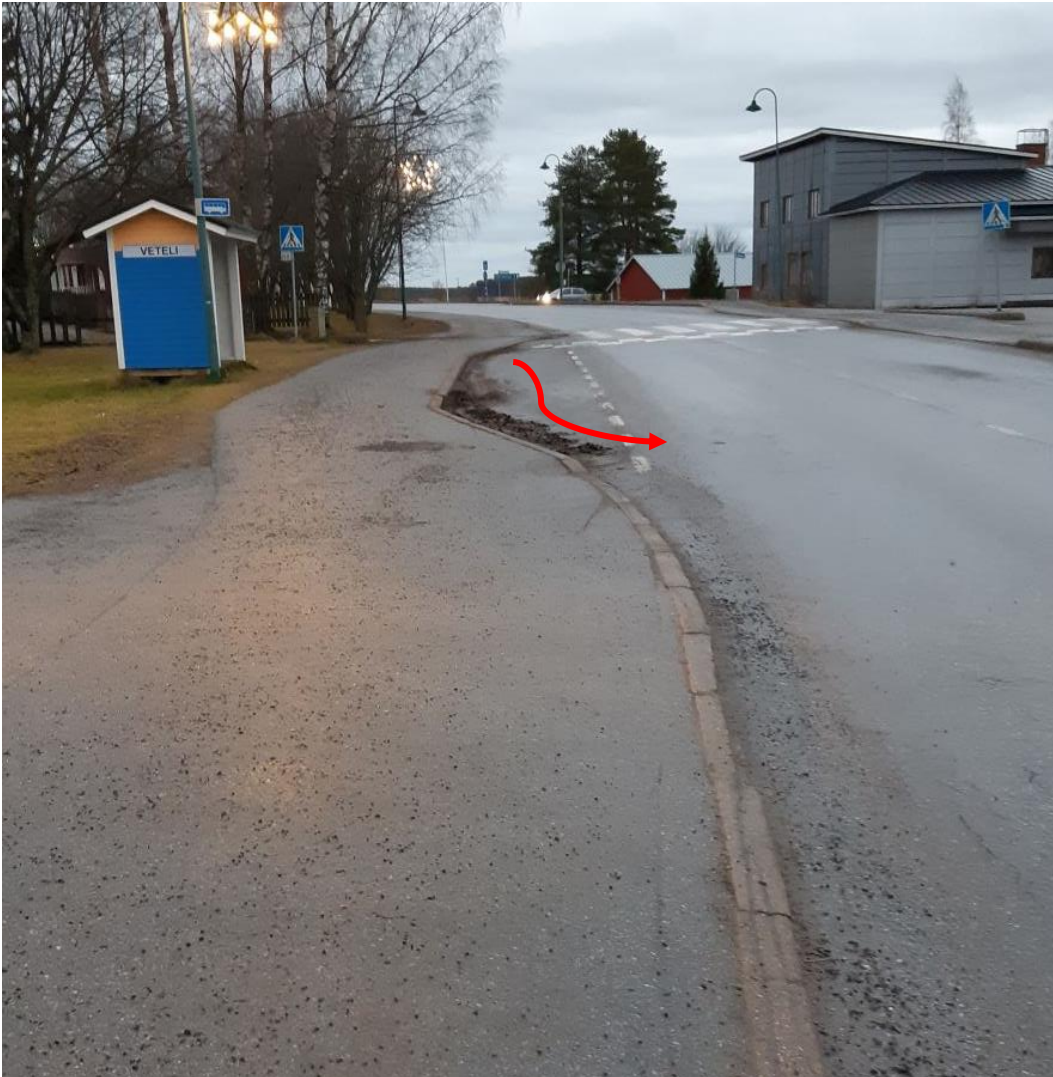
Kuva 3. PI 1/2020 bussipysäkille lammikoituu vettä ja kerääntyy roskaa. Korjataan parantamalla kaatoa.
