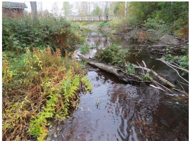
Rännin pohjoispää, kunnostettu kävelysillan kohdalla.
