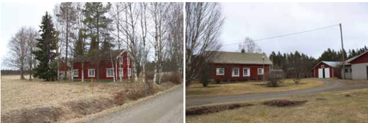
Kuva 56. vasemmalla: Siirintupa kuvattuna lounaasta. Kuva 57. oikealla: 1988 valmistunut asuinrakennus, jonka vasemmalla puolella muita piharakennuksia. (Arkkitehtitoimisto Lukkaroinen Oy 2016)
