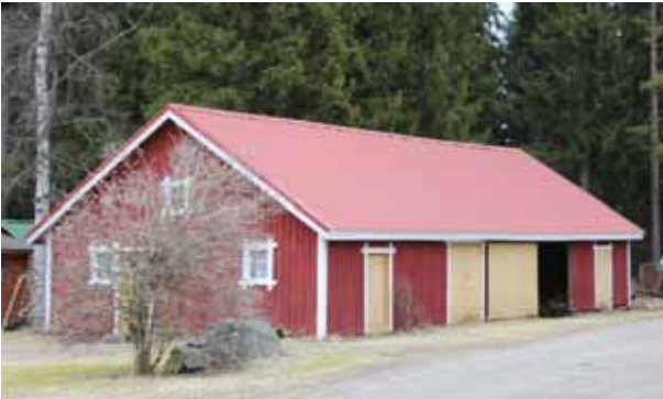
Kuva 34. Rauhalan alkuperäinen piharakennus. (Arkkitehtitoimisto Lukkaroinen Oy 2016)
