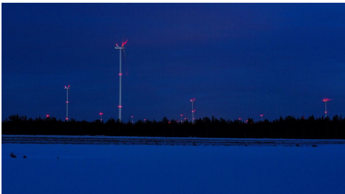
Kuva 38. Kiinteät punaiset lentoestevalot pimeällä. (Kuva: Ville Suorsa/FCG)
