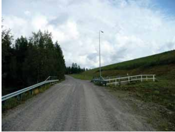
Kuva 34. Patanan tekojärven pato ja juoksutuskanava.
